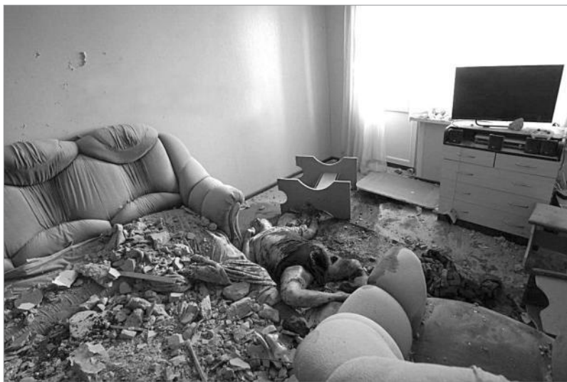
На фото последствия украинского обстрела из РСЗО 23 февраля 2023 года Буденновского района г. Донецка, ул. Октября, 22а
