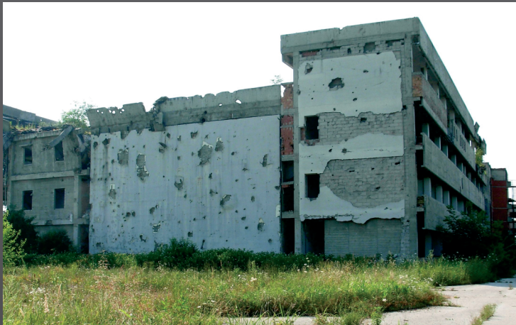
Разрушенное натовскими бомбардировками здание телеканала в Мишелуке
